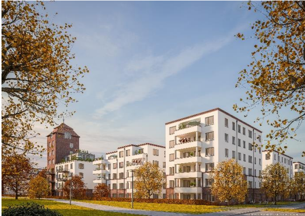
Letzter Bauabschnitt „ISABELLA S in den Nordstadtgärten“
